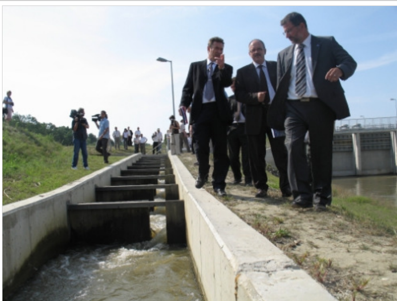
Az erőmű mellett kialakított hallépcső biztosítja a vízi élőlények szabad vándorlását a folyóban.
