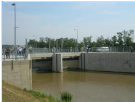
2,1 millárdba került az erőmű megépítése
