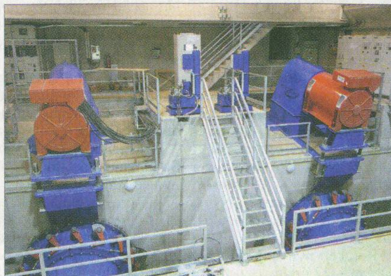
A kétturbinás kiserőmű a Rába vízi energiáját hasznosítja
