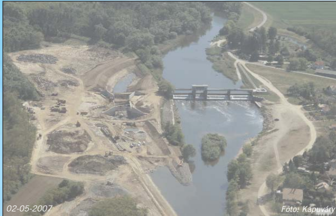
Das erste größere Kleinwasserkraftwerk in Ungarn seit über 50 Jahren entsteht an der Raab unweit von Répcelak. Rund 8,2 Mio. Euro kostet die Anlage.
