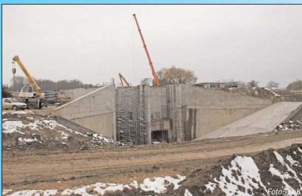
Im Januar sollten die Bauarbeiten für das Kraftwerk abgeschlossen sein.
